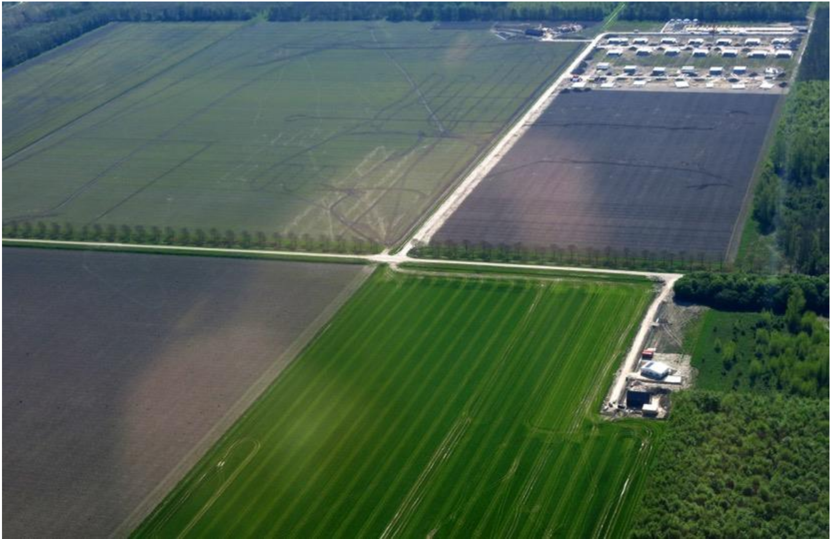
En aan de overkant, in het VTZ-gebied, werd in 2016 ook met de bouw gestart.
