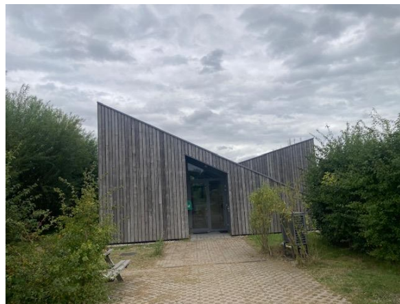
ontmoetingsgebouw op Vuurstenhof (THF)
